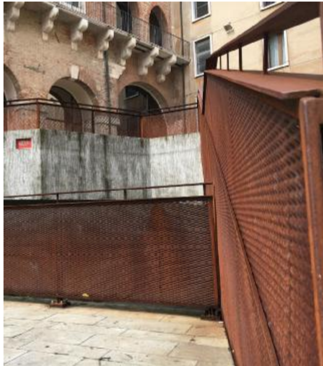
Il parapetto in Cor-Ten che è stato realizzato durante il restauro
